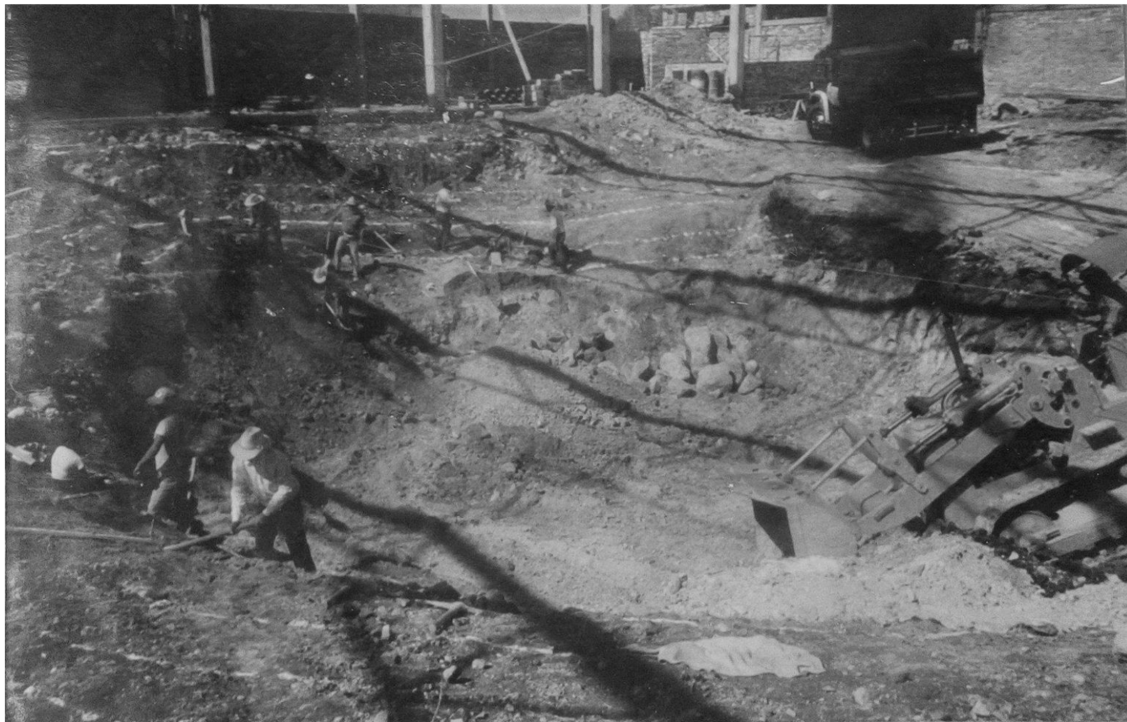
CONSTRUCCIÓN DEL PALENQUE MUNICIPAL
